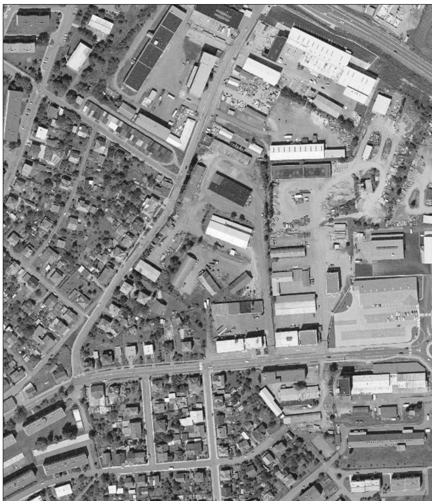
Obr. 11. Poslední letecký snímek zbytku dvora U Merunků (dříve zvaného Říha; k. ú. Havlíčkův Brod) pohlcovaného městem. Dnes jsou již oba poslední objekty, které z někdejší obvodové zástavby dvora zbyly, zbořeny. ( http://www.mapy.cz/# )
