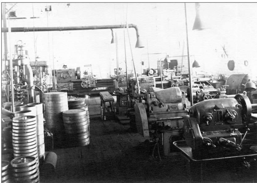
Interiér strojírný ve 30. či 40. letech minulého století. Archiv J. Nagyová
