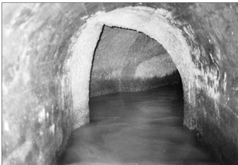
Obr. č. 4 - Zatopená chodba pod domem čp. 156 v Dolní ulici (foto S. Šíl).
