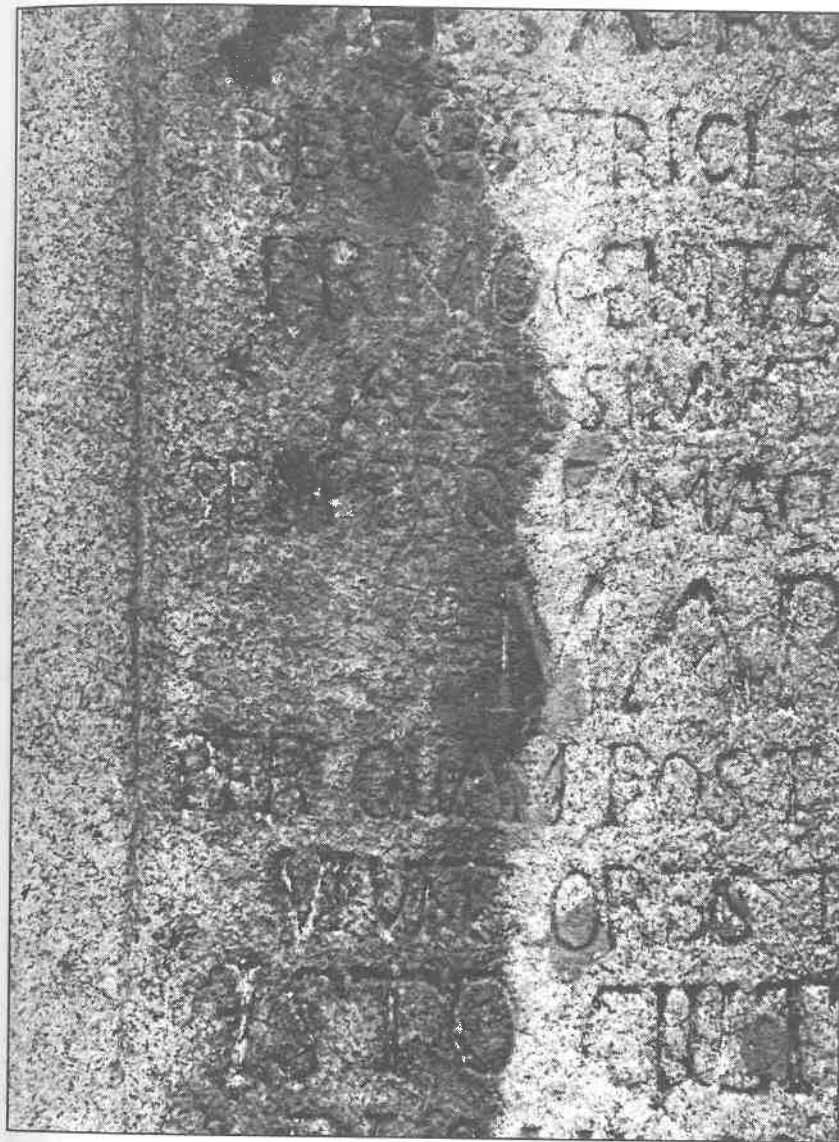
Ledeč nad Sázavou - mariánský slou, čelo podstavce, nápisová partie; granit : poškození kamene deštěm a mikroorganismy (růst mechů a lišejníků ve spárách písmen; vytváření barevně kontrastních pásů vlivem splavování depozitů a vegetace z římse)
