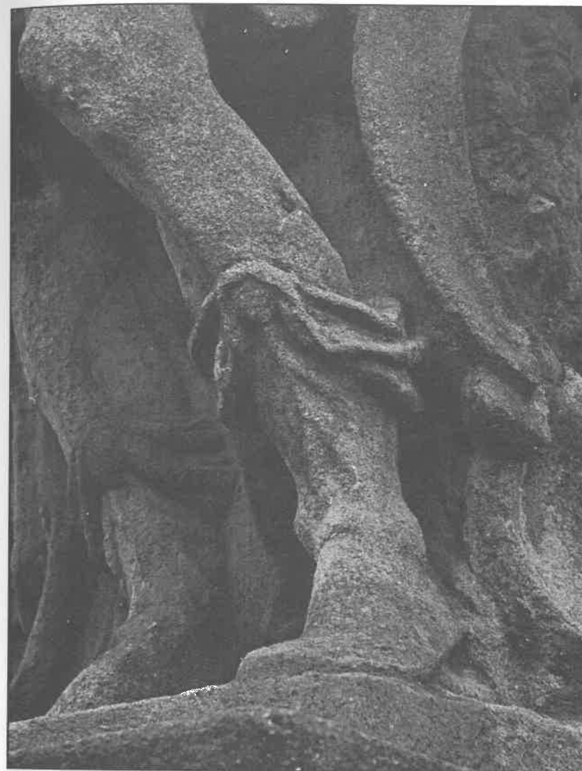
Ledeč nad Sázavou - mariánský sloup, socha sv. Václava, detail levé nohy; „mušlový“ pískovec : z pentle v podkolení sochy byl odebrán vzorek pro mikroskopické vyšetření polychromie (výsledky - viz text)
