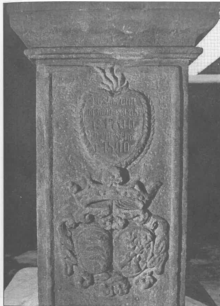
Chotěboř - mariánský sloup v parku, reliéf na čele podstavce; pískovec: fragmentárně zachovalá polychromie ve spárách a podhledech (bližší pojednání - viz text)
