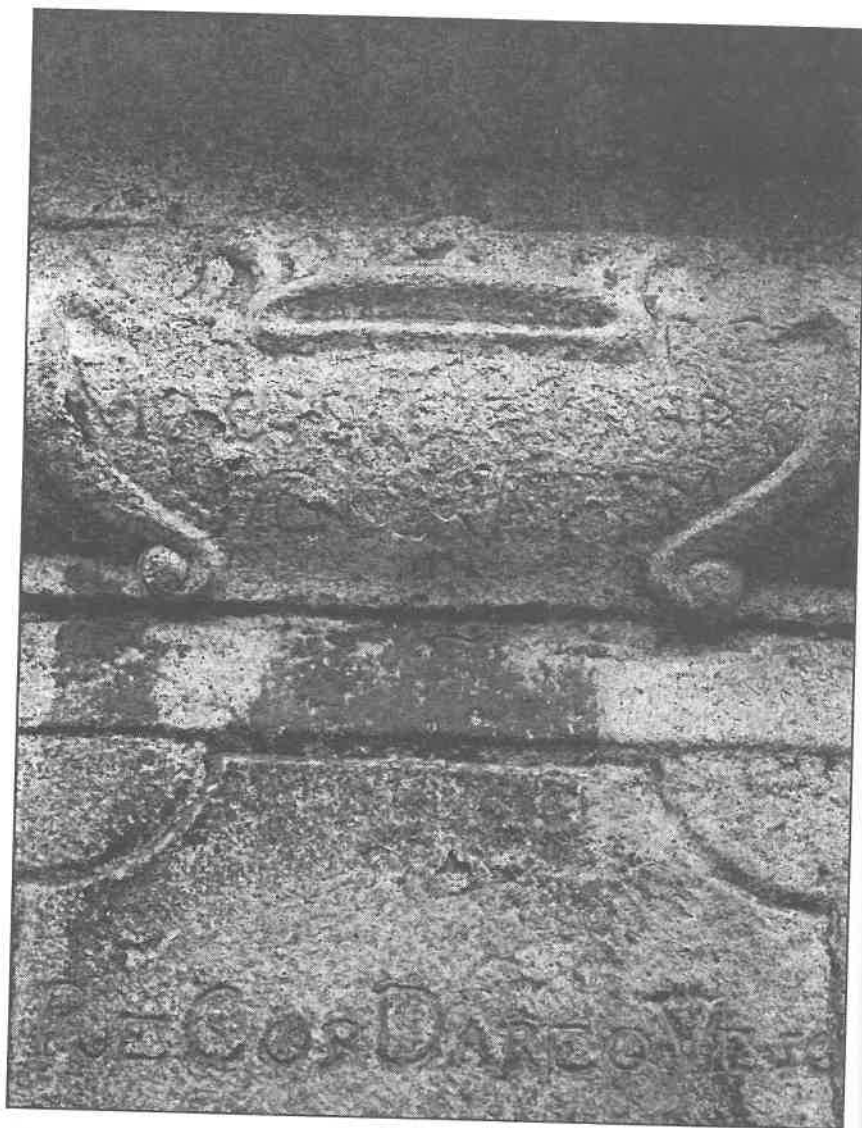
Zahrádka - mariánský sloup, čelo podstavce, nápisové partie; granit: koroze povrchové vrstvy kamene (způsobená zřejmě aplikací nevhodných konzervačních prostředků v minulosti) vedoucí k destrukci nápisů; spodní část nápisů z čela podstavce byla v minulosti několikrát barevně pojednána (výsledky mikroskopického vyšetření polychromie - viz text)
