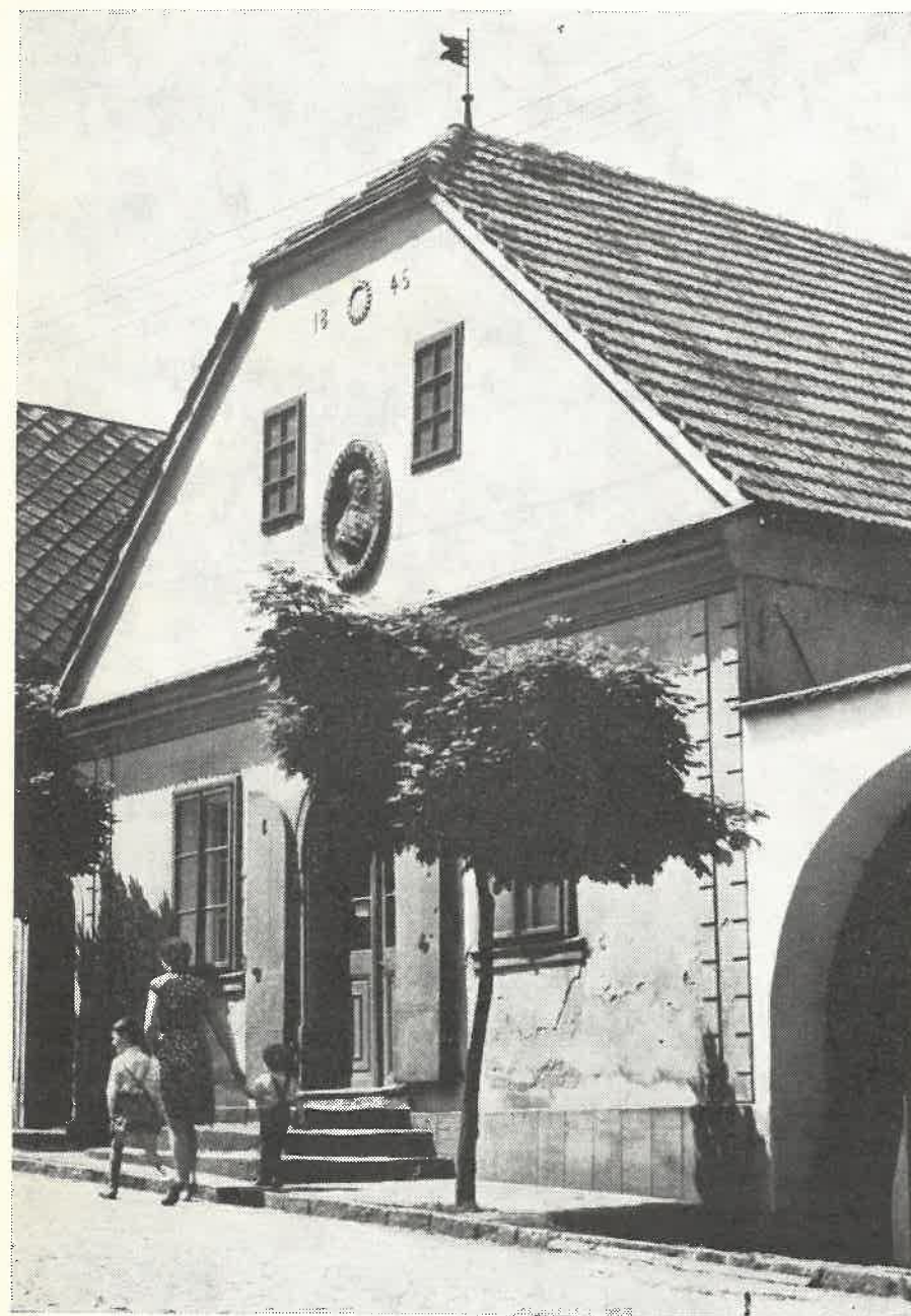
Havlíčková Borová — Havlíkův rodný domek, v němž byl v roce 1931 vybudován Havlíkův památník a v roce 1970 zde byla provedena reinstalace. — Foto ing. K. Korba.
